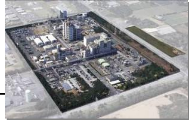
Kashima Factory (Kamisu-shi, Ibaraki, Approx. 130,000 m 2 )
