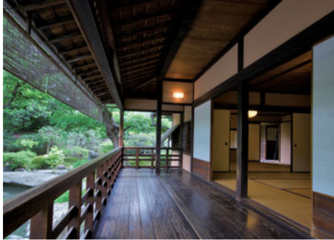
拾翠亭の土壁は赤みがかった錆土仕上げ
